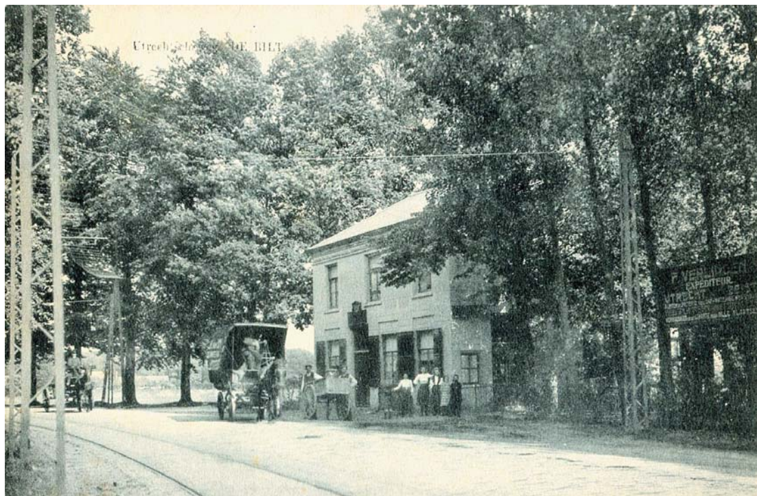
Fig. 4 Café Plant, met speeltuin. Het voormalig tolhuis is inmiddels met een verdieping uitgebreid. Datering: onbekend. Bron: Beeldbank Historische Kring D'Oude School.
