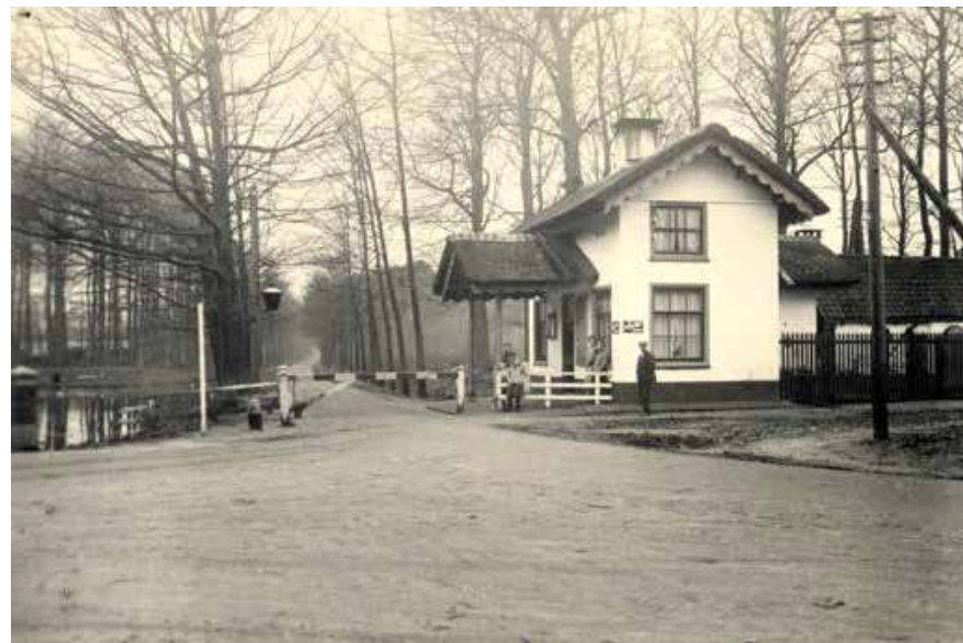
Het Veenhuizer tolhuis, kijkend in de richting van De Bilt. Voor de tol links de Veenhuizerweg (verhard), rechts de Hessenweg (onverhard). Datering 1924-1928 (HUA, cat.nr. 220771).
