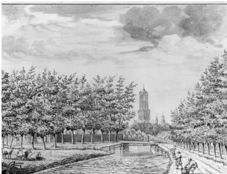
Figuur 2: 'Gesicht op de Biltstraat buyten Utrecht', met op de achtergrond onder andere de Domtoren. Vervaardiger: D. Verrijk. Datering 1755-1765. Bron: Het Utrechts Archief, cat.nr. 35192.
