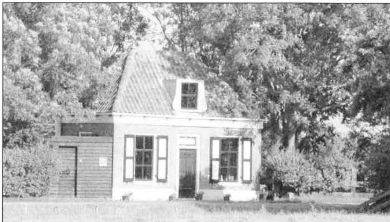
Afb. 9 Tolhuis van de Stadter Tol aan de Hoeverschelpweg, Egmond aan den Hoef. Foto: Kees Floor, 2007.
